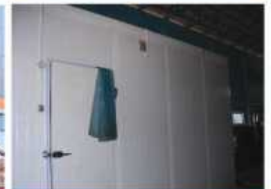
Cold storage kapasitas 50 ton
